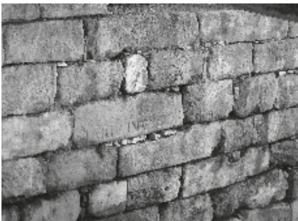
FIGURA 6. Detalle de la cimentación de la basílica cristiana en las fosas del anfiteatro. Se pueden apreciar las losas de la gradería, una de las cuales aún conserva su epígrafe identificativo. Curiosamente la mayoría de los epígrafes reutilizados se encuentran con el texto invertido (TED'A 1990, 160-173).
