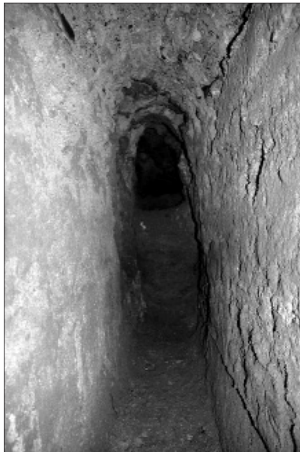
Fig. 50: Extrem meridional del segment recentment excavat de cuniculus. Volta amb encofrat perdut realitzada en opus caementicium. Foto: J. M. Macias.
