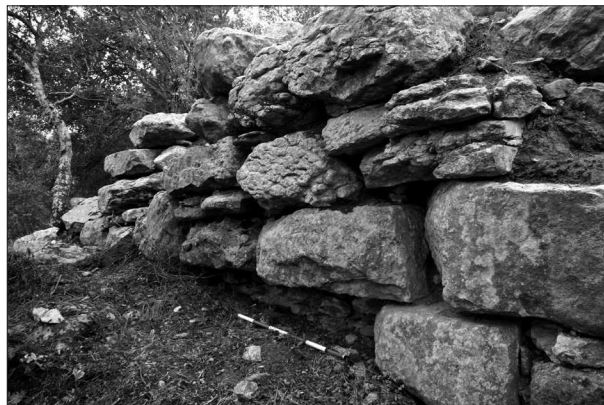
Figura 3. Fonamentació de la torre sobre roca mare en el mur MR 1005.
