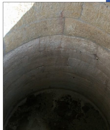
Detalle de la pared y el fondo de la cisterna ibero-romana construida a finales del siglo II o inicios del siglo I a.C. en La Vispesa (Tamarite de Litera, La Litera, Huesca). Foto de los autores.
