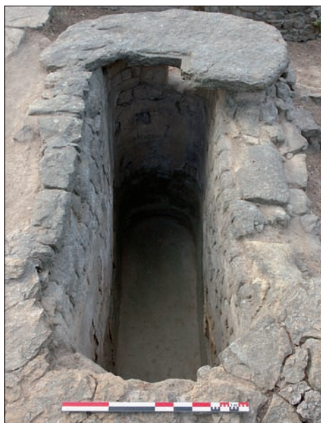
Cuidada cisterna elíptica del Puig de Sant Andreu (Ullastret, Baix Empordà, Girona). La forma elíptica y el acabado impermeable de mortero son influencias recibidas de la cercana colonia griega de Ampurias, siglo III a.C. Foto: Museo de Arqueología de Cataluña (Ullastret).
