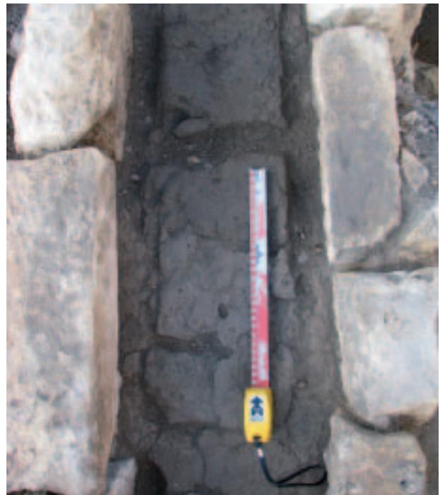
Fig. 3.79. Détail des briques au fond du caniveau CN170011.
