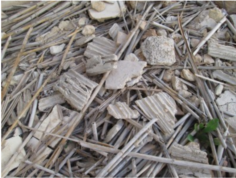
Restes constructives en una construcció recent enderrocada. Imatge: Belarte i Pastor (2021).
