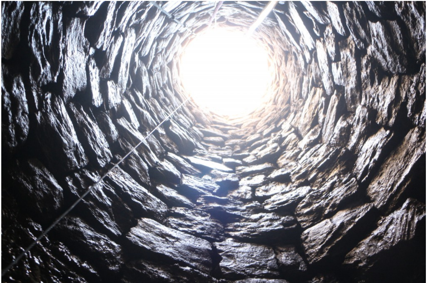
Vista de l'interior del pou (@ Equip Iesso)
