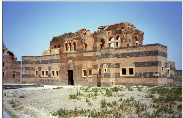
Fig. 1.4 Vista del palacio desde el Sureste. Se puede apreciar la técnica constructiva basada en la alternancia de la piedra basáltica y el ladrillo.
