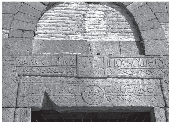
Figura 9. Dintel de la puerta de entrada en el ala sur del palacio. Se puede apreciar el esquematismo de la decoración vegetal y la simbología cristiana. La inscripción en griego ha proporcionado la datación del edificio en el año 564 (A. Perich).
