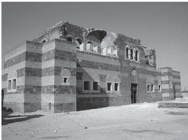
Figura 2. Vista general del palacio desde el suroeste. Se puede apreciar cómo la restauración ha seguido la técnica constructiva original a base de hiladas alternas de ladrillo y piedra basáltica (imagen: A. Perich).
