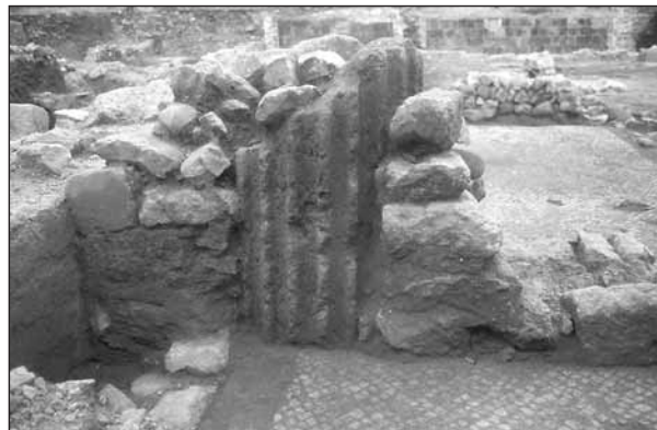
fig. 65: Detall del mur UE 1262, que aprofita elements constructius previs
