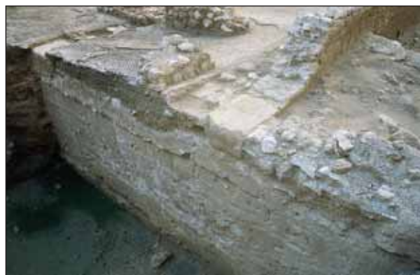
fig. 26: Detall mur 1120 amb les estructures posteriors sobreposades
