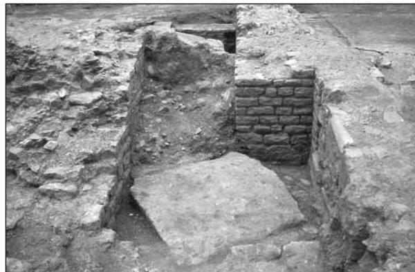
fig. 53: Detall de l'àmbit XI amb la porta d'accés a la sala IX tapiada i amb la coberta del registre de la canalització inferior
