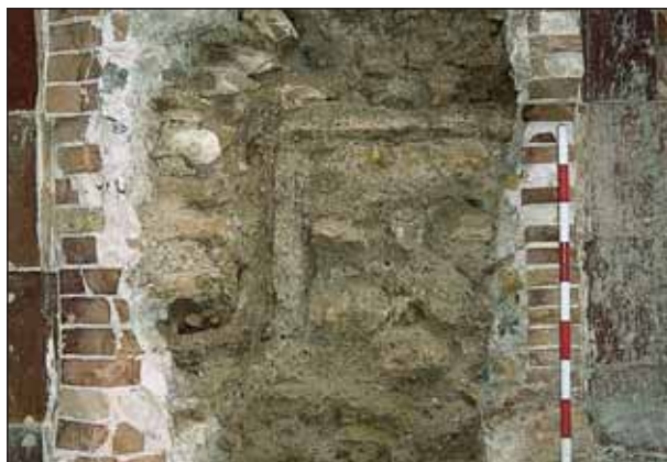
fig. 43: Detall del revestiment hidràulic del mur 1950. Àmbit VI
