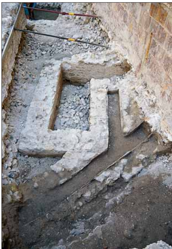
fig. 23: Detall canalitzacions 1911 i 1912 amb el farciment d'obliteració intern i els rebliments constructius de graves
