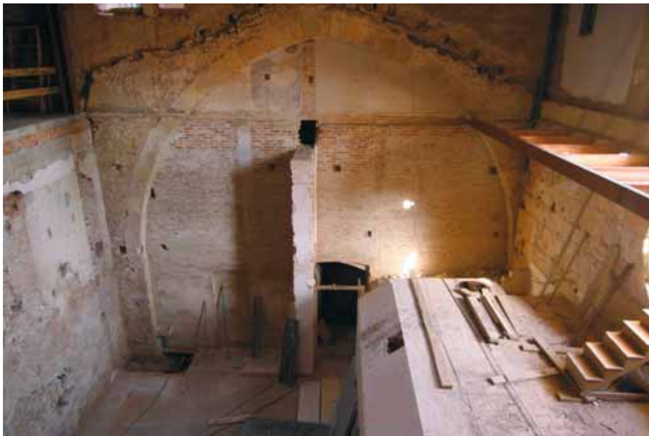
Gran arc diafragma descobert a l'ala nord-est del claustre durant els treballs de rehabilitació del nou Museu Diocesà
