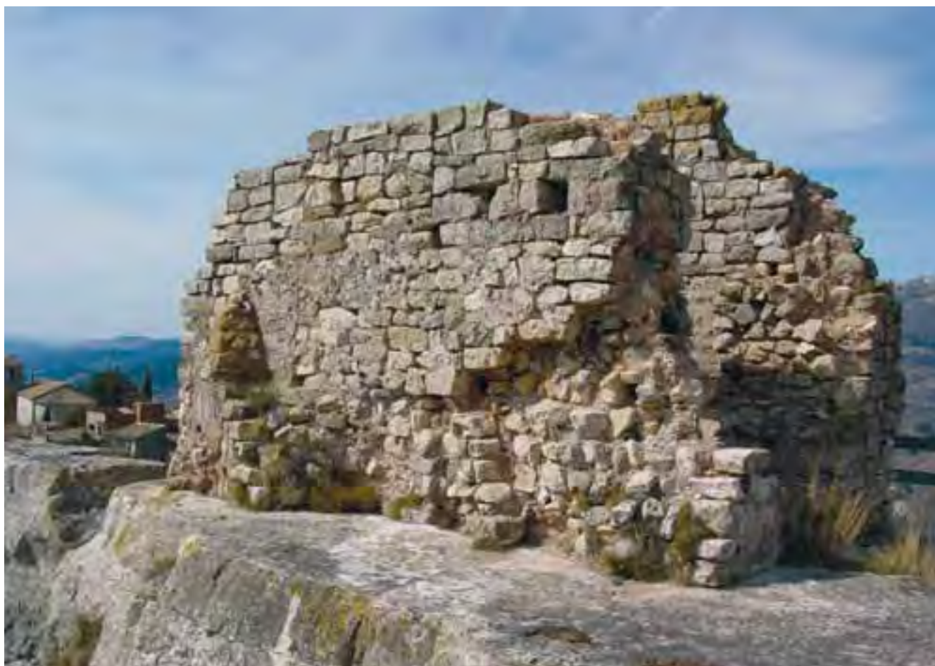
Torre del hisn de Siurana, un dels castells ( husun ) que controlaven la marca extrema d'Al Andalus
