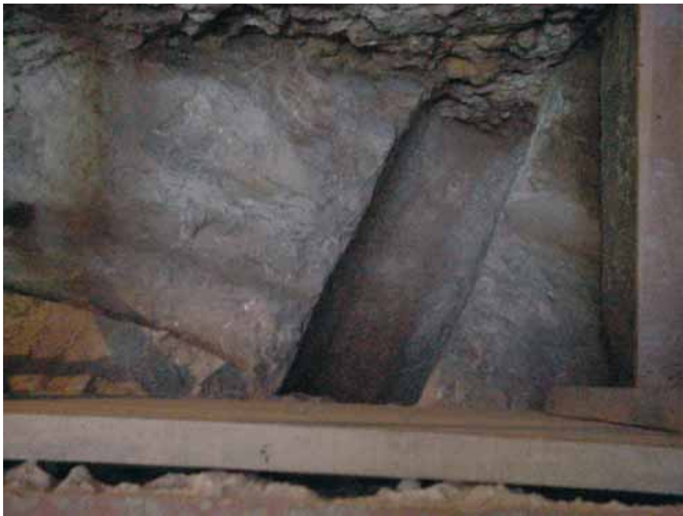
Conducció excavada a la roca (segle I dC), localitzada darrere de la capella de la Confraria de Santa Tecla
