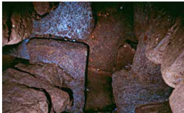
Fig. 5: Estat de conservació de l' hypocaustum sota l' alveus del caldarium
