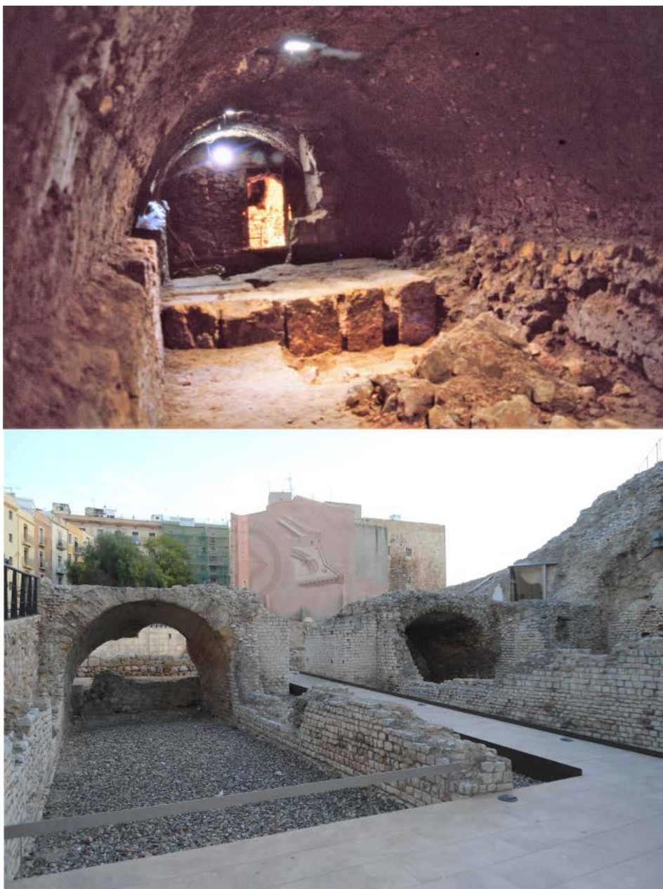
Figura 4. L'ús diferenciat de paraments: en la part superior parets d' opus caementicium desencofrat de la volta longitudinal situada sota el carrer dels Ferrers, amb la base de grua feta de carreus en el centre (Arxiu Ll. Piñol). En la part inferior les voltes d'accés des de la via Augusta, amb les parets acabades en opus vittatum (Arxiu Codex).
