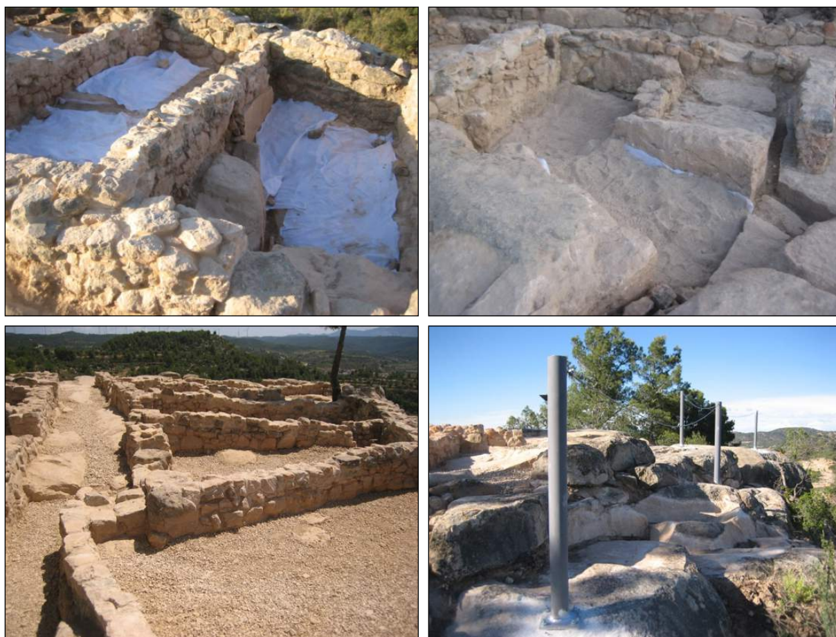
Figura 6. Vista del procés de museïtzació. Cobriment del terreny natural amb geotèxtil, després amb sorra i acabat amb grava. Detall de la protecció metàl·lica
