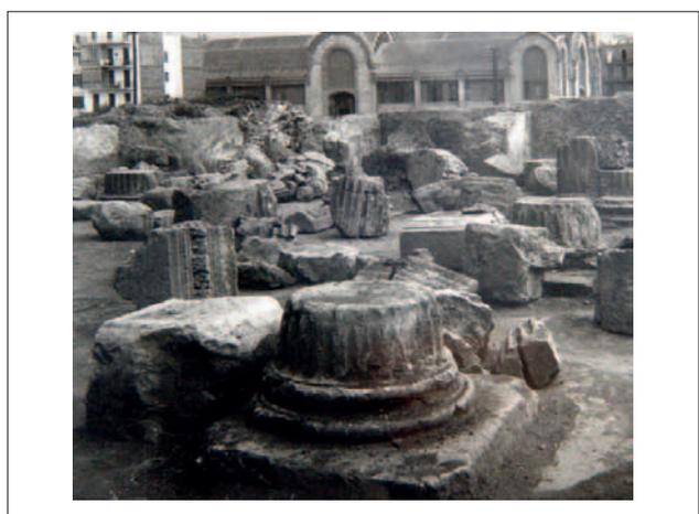
Fig. 21. Fotografía de Serra Vilaró (1932, lám. 4) que permite ver la rotura del primer pavimento de la basílica para instalar las basas áticas de una nueva columnata.
