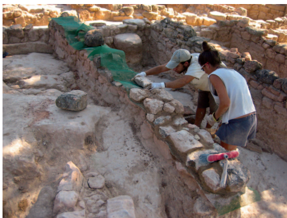
Fig. 4. Consolidació de murs amb el recreixement de la capa de salvament i la malla de PVC.
