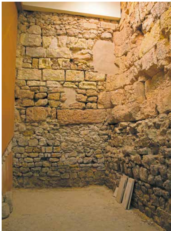
12 Vista exterior de l'angle nord-occidental de l'exedra oriental del porticat del recinte de culte (foto: Jordi Granell)
