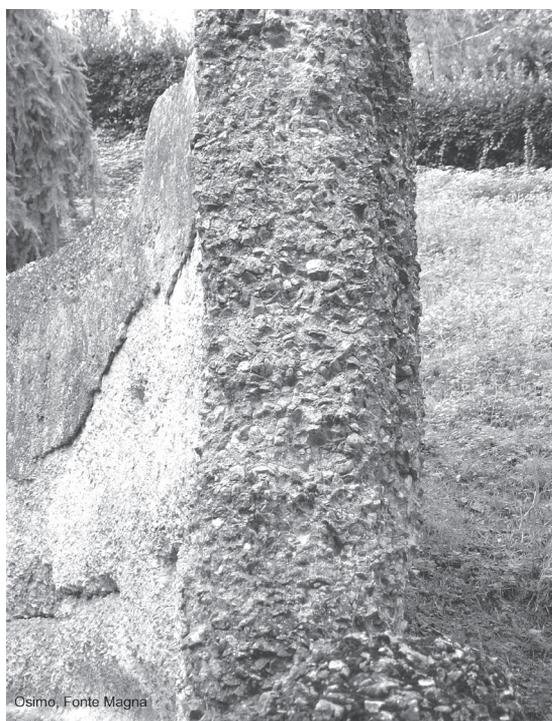
*Figura 2. Sección de un muro en opus signinum (GIULLANI 2006).*
