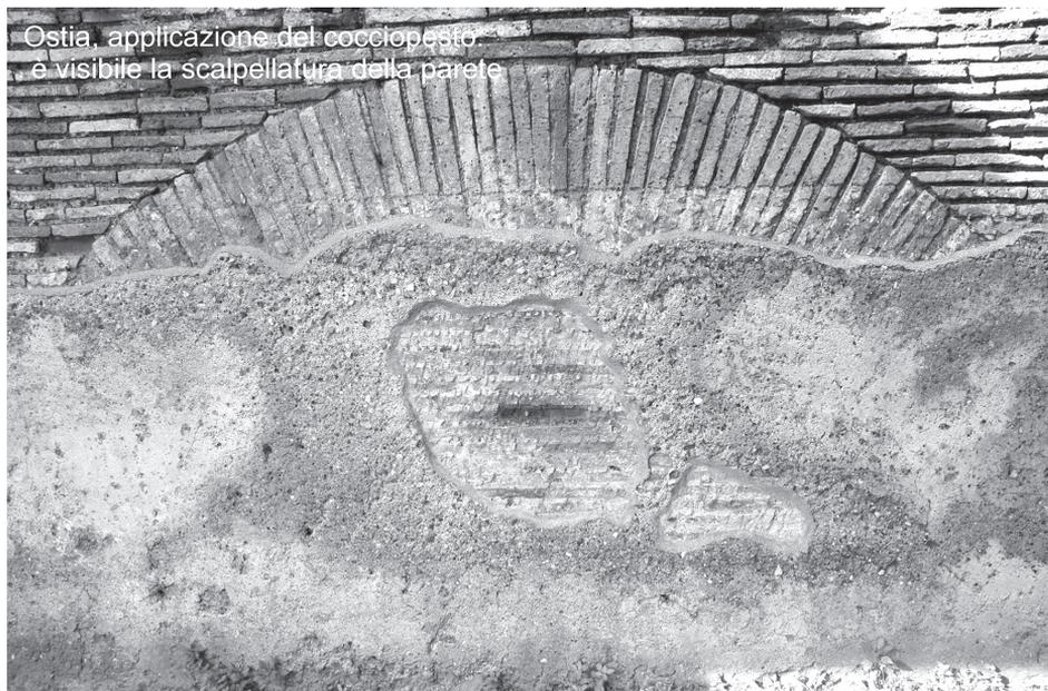
*Figura 4. Revestimiento en cocciopesto (o si se prefiere ostracus o testaceum o pavimento de cascotes) (GIULIANI 2006).*
