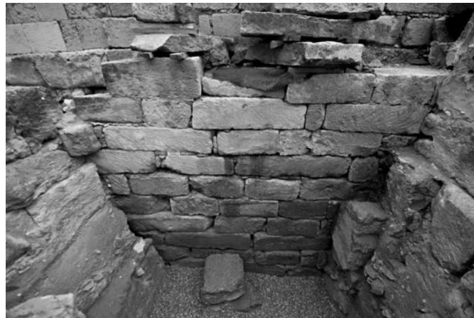
Figura 10 Vista d'ull de peix i frontal de la fonamentació septentrional de la basílica de l'amfiteatre. Als laterals s'aprecia la fonamentació dels murs de la cambra funerària/baptisteri i també la rasa de fonamentació de la nau de finals dels segles VI – inicis del VII. [Fotografia: Josep Maria Macias – Arxiu ICAC]
