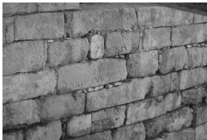
Figura 11 Detall de la fonamentació de la basílica visigòtica de l'amfiteatre. [Fotografia: Josep Maria Macias – Arxiu ICAC]
