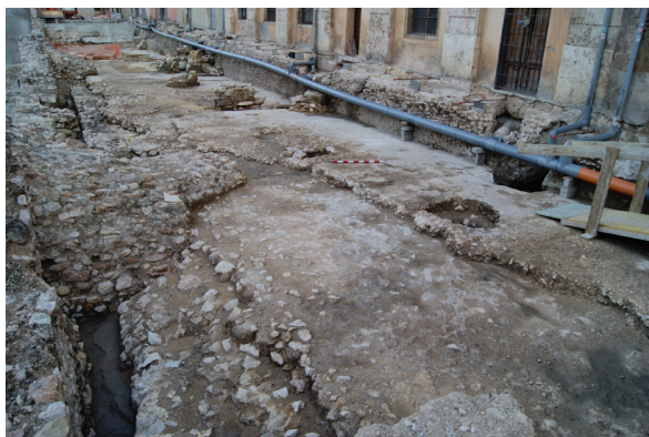
Figura 5. Estat de conservació de la plataforma plana del visori i l'extradós de la volta
