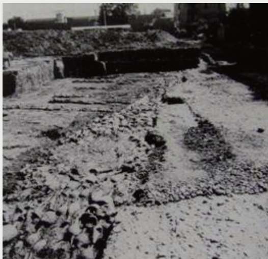
Figura 23. Parma, via Palermo: sistemazione di anfore al di sotto della glareata della via Parma-Brixellum (da MARINI CALVANI 1992).
