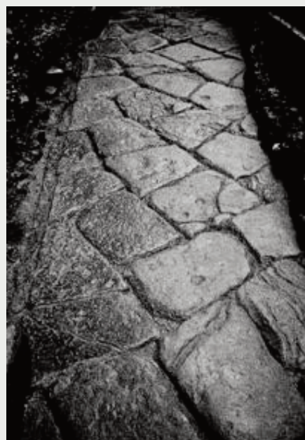
Figura 4. Regium Lepidi (Reggio Emilia): tratto urbano della via Aemilia in blocchi quadrangolari di arenaria (da ORTALLI 2000).
