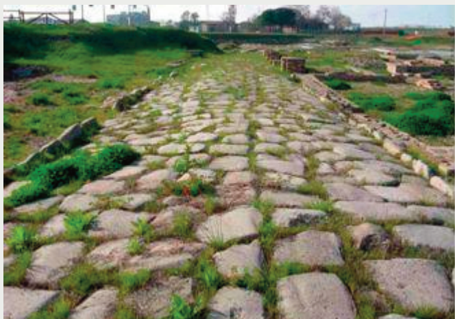
Figura 5. Strada basolata in poligoni di trachite attraversante l'antico centro portuale di Classis (Classe, Ravenna).
