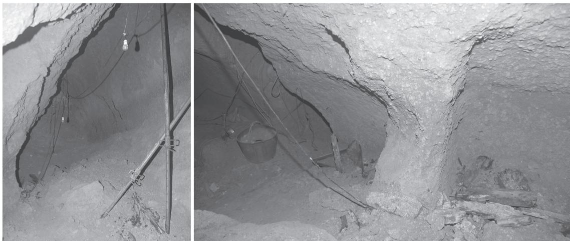
Figura 7. Detalle del derrumbe de la galería principal (Foto Hèctor Juan Sanmartín, 2012).
