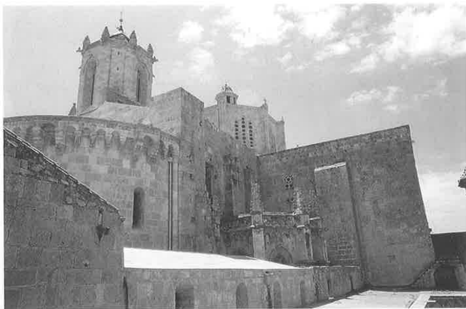
FIGURA 3. Capçalera de la catedral després de la restauració.
