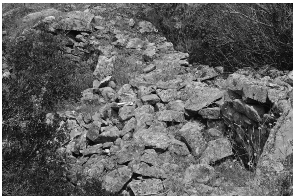
Figura 10. Mur de pas o “pont” que mena cap a la plataforma on està situada la torre.
