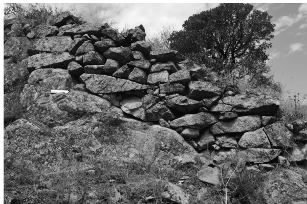
Figura 9. Mur de tancament est de la plataforma on està situada la torre.
