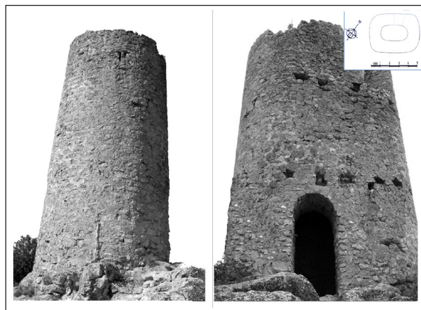
Figura 3. La torre del Moro (Montferri). A l'esquerra, cara nord, on s'observa una espitllera original. A la dreta, cara oest, on destaca la presència d'encaixos per a la bastida, així com la seva planta arqueològica (Autors diversos, 1995).
