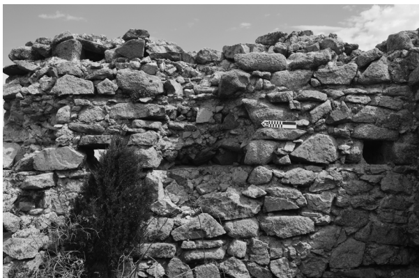
Figura 7. Detall de l'encofrat dels murs de la torre de Castellfolit (Vimbodí i Poblet).
