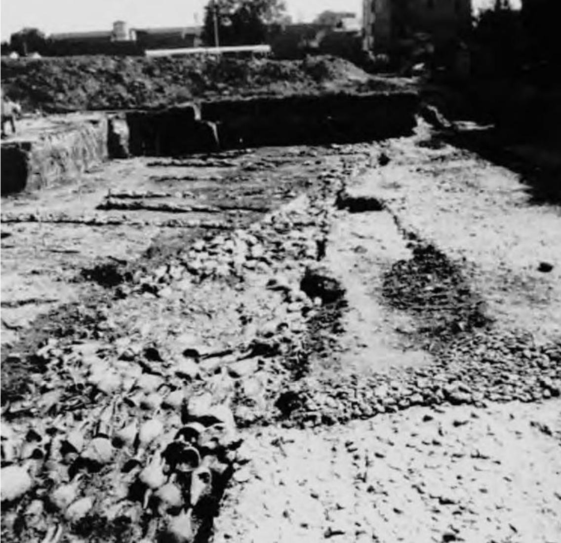
Fig. 2. Bonifica con anfore impiegata per sottofondare la massciata della via Parma-Brixellum
