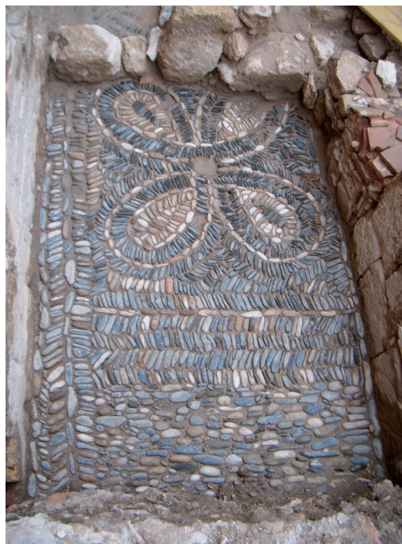
Figura 25. Detall del paviment del petit carrer que articula els habitatges (Arxiu CODEX)
