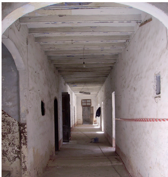
Figura 20. Detall d'un dels passadissos distribuïdors de les cel·les (Arxiu CODEX)
