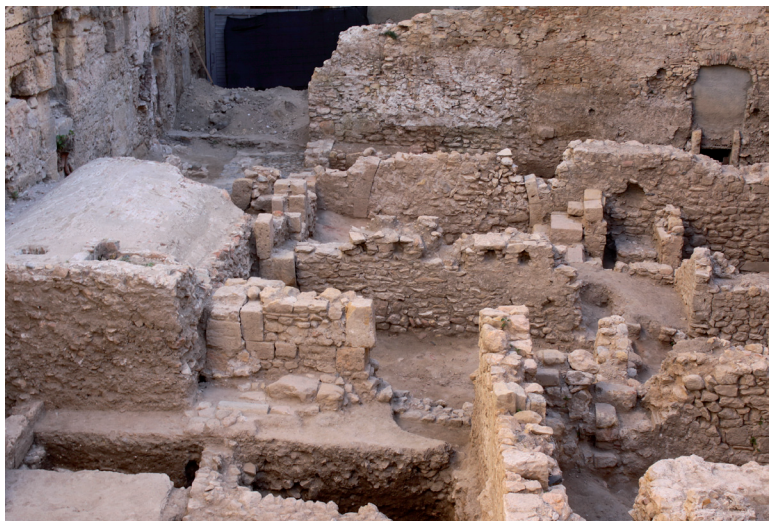
Fig. 11. Detall de les parets de les cases bastides al segle XIV. En primer terme l'àmbit VII, que conserva els encaixos de les bigues que sustentaven la planta baixa (Arxiu CODEX)
