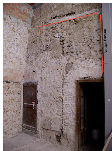
Fig. 5. Detall de la façana de cases medievals en el tram del vial que connectava directament la plaça del Pallol amb el carrer de l'Arc d'en Toda, previ a la urbanització del segle XIV (Arxiu CODEX)
