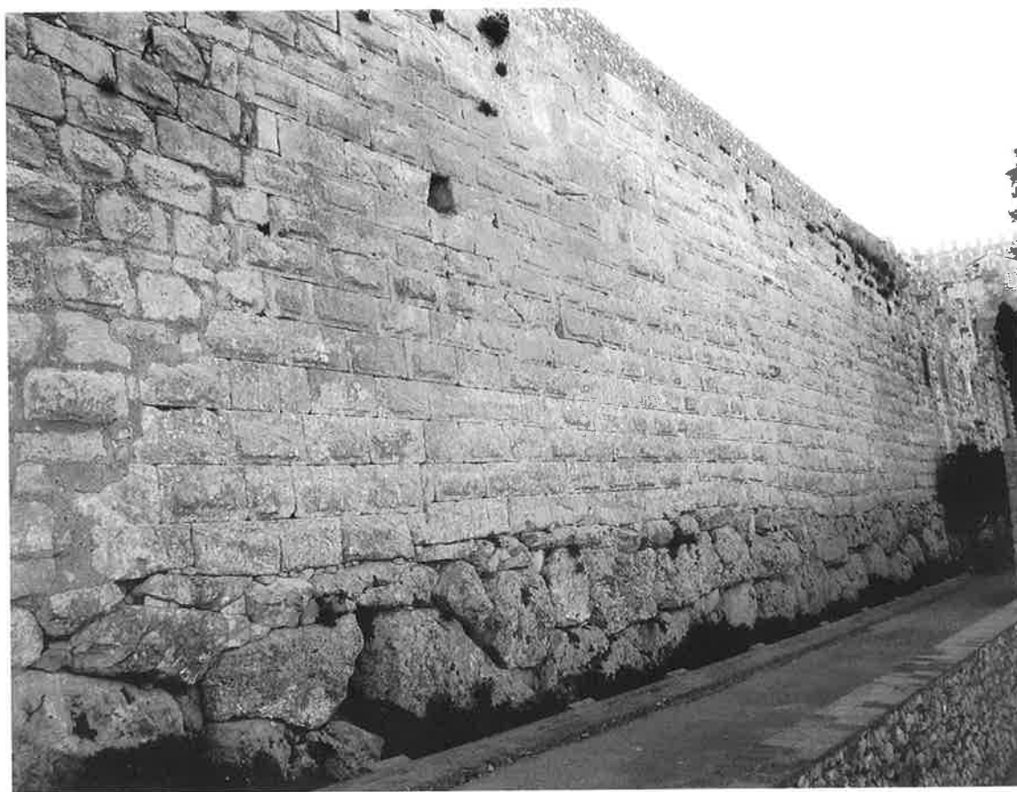
Fig. 203: Muralla romana de Tarragona. Vista d'un dels llenços millor conservats. (López)
