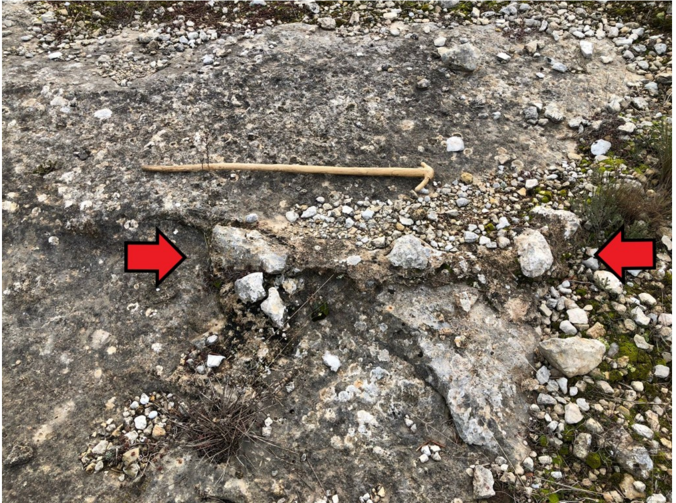
Pedres lligades amb morter de calç sobre la roca, única resta de la fonamentació de l'aqüeducte.
